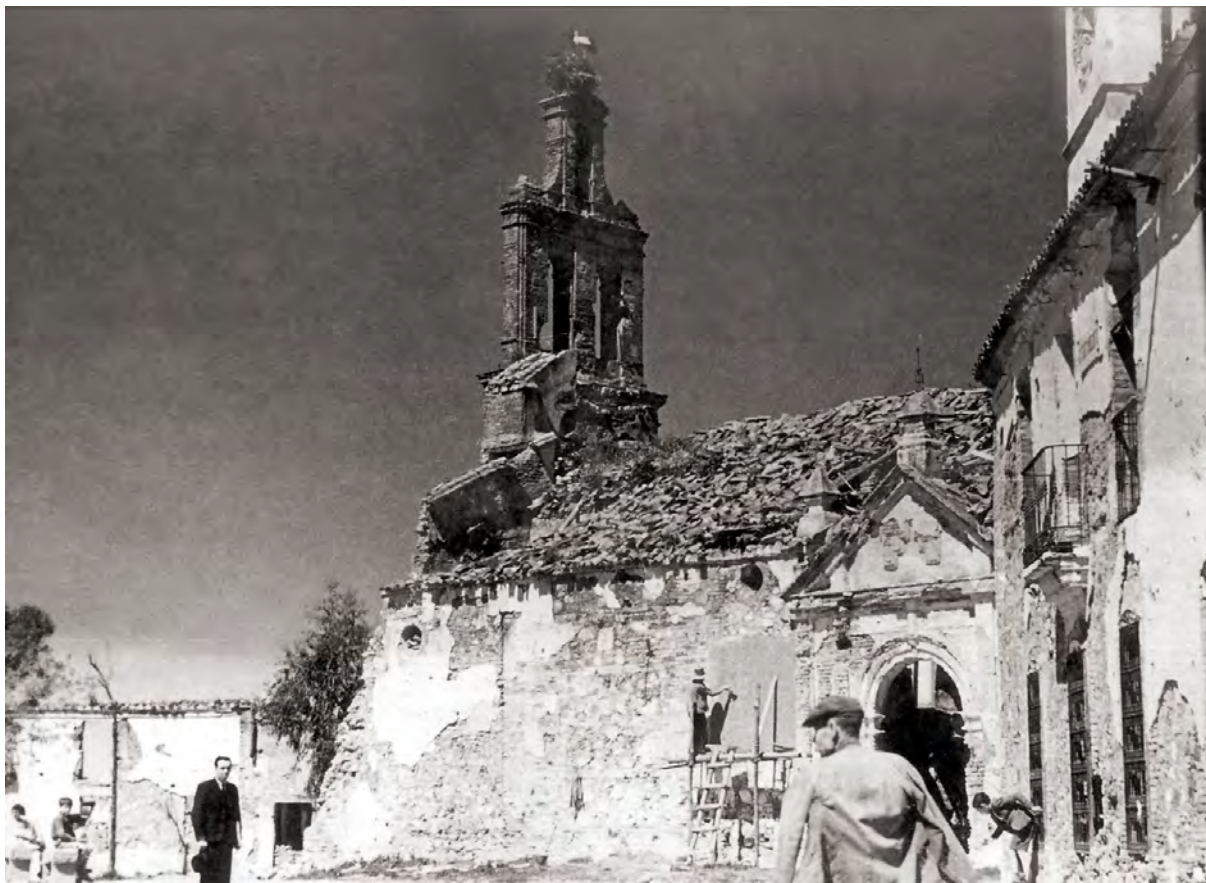
Torre de la iglesia de Valsequillo en 1937 (Fuente:Junta de Andalucía. Regiones devastadas).
